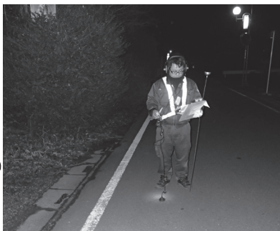
夜間漏水調査の様子
