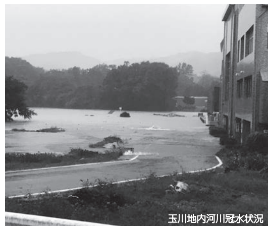
玉川地内河川冠水状況
